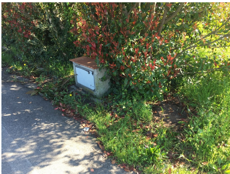
Foto 4-5: Pozzetto fognatura nera, contatore acqua (sopra) e allaccio elettrico.
